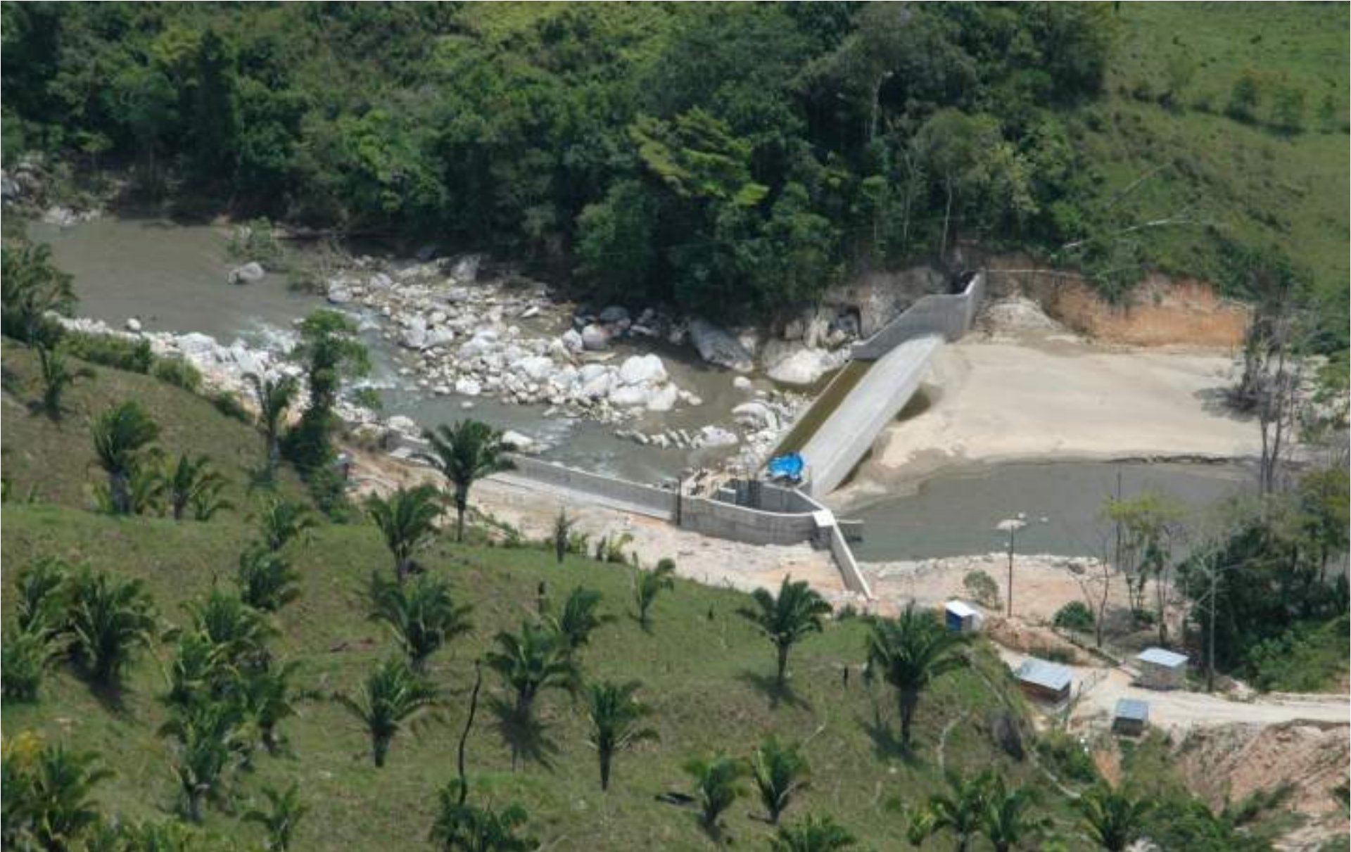
“REPRESA HIDROELECTRICA BALFATE, DISEÑO QUE FALLO EL 25 DE DICIEMBRE 2006”
